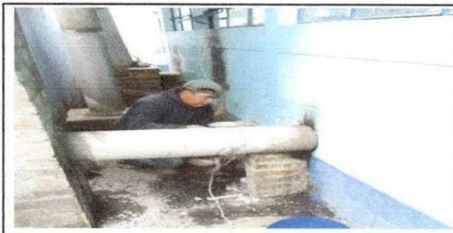
Foto 6: Reparación de cocina.
