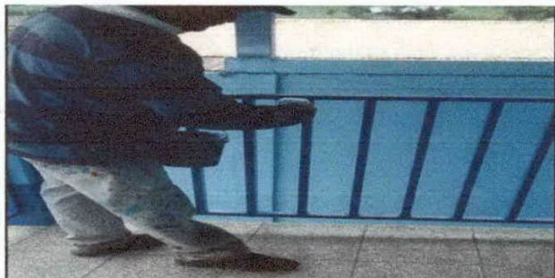
Foto 3: Mantenimiento a barandas.
