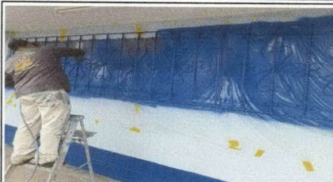
Foto 8: Mantenimiento a Balcones de Metal
