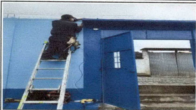
Foto 7: Reparación Sistema Eléctrico Parte 2
