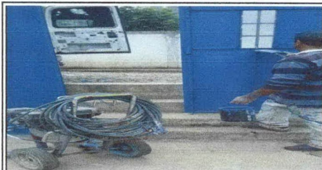
Foto 4: Mantenimiento a portones.
