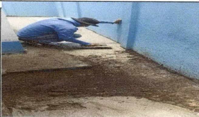
Foto 10: Reparación de piso de torta de concreto
