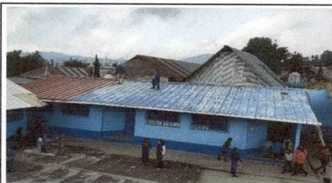
Foto 9: Mantenimiento de lámina troquelada
