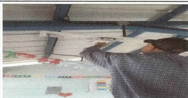
Foto 5: Reparación de sistema eléctrico.
