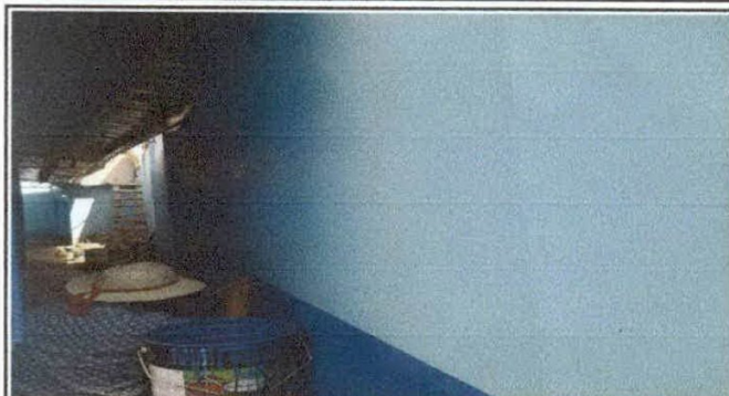
Foto 2: Pintura en muros exteriores e interiores.
